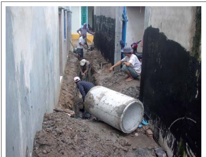
សកម្មភាពធ្វើប្រព័ន្ធប្រឡាយលូបង្ហូរទឹកស្អុយសហគមន៍ Urban Community Sewerage drainage activity
