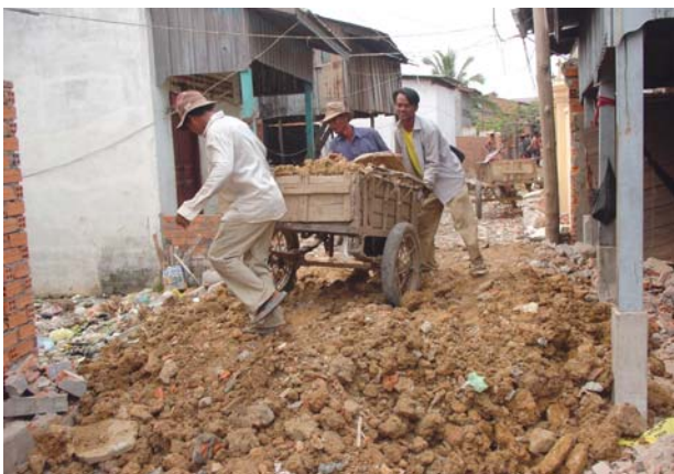
Filling community alleyway activity សកម្មភាពចាក់ដីធ្វើផ្លូវលំតូចសហគមន៍
